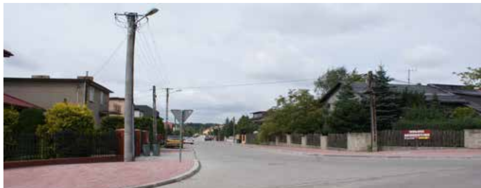
Budowa ul. Żytniej na odcinku od skrzyżowania z ul. Polną do posesji nr 54, ulicy bez nazwy oraz skrzyżowania ulicy Polnej z ul. Żytnią – wykonanie jezdni, obustronnych chodników, zjazdów indywidualnych
