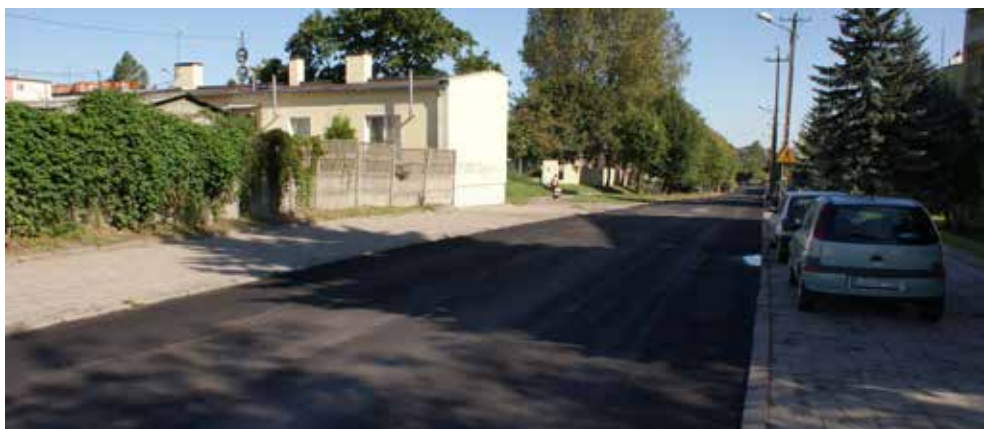
Położenie nowej nakładki asfaltowej na ul. Cezaka (w trakcie prac)
