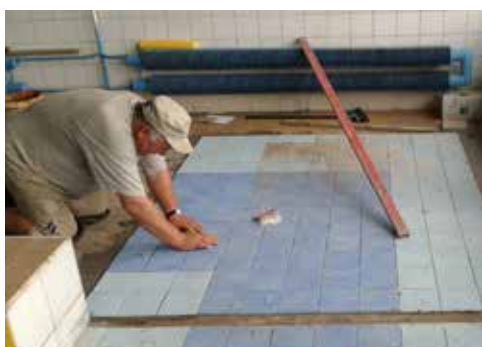
Wymiana płytek na pływalni
