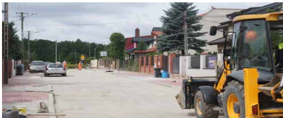
Budowa ul. Żytniej na odcinku od posesji nr 66 do posesji nr 86 oraz ulicy bez nazwy – wykonanie jezdni, obustronnych chodników, zjazdów indywidualnych
