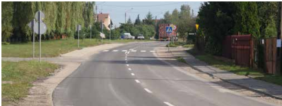
Przebudowa ul. Adolfa Dygasińskiego na odcinku od wiaduktu drogowego na ul. Czerwieńskiego do ulicy Kasprowicza – poszerzenie istniejącej jezdni, wykonanie utwardzonych poboczy z flucznią, zjazdów do dróg poprzecznych oraz brakującego odcinka chodnika
