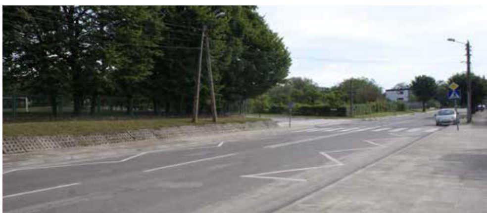
Wymiana chodnika na ul. Rembieleńskiego, na odcinku od wiaduktu do ul. Majakowskiego
