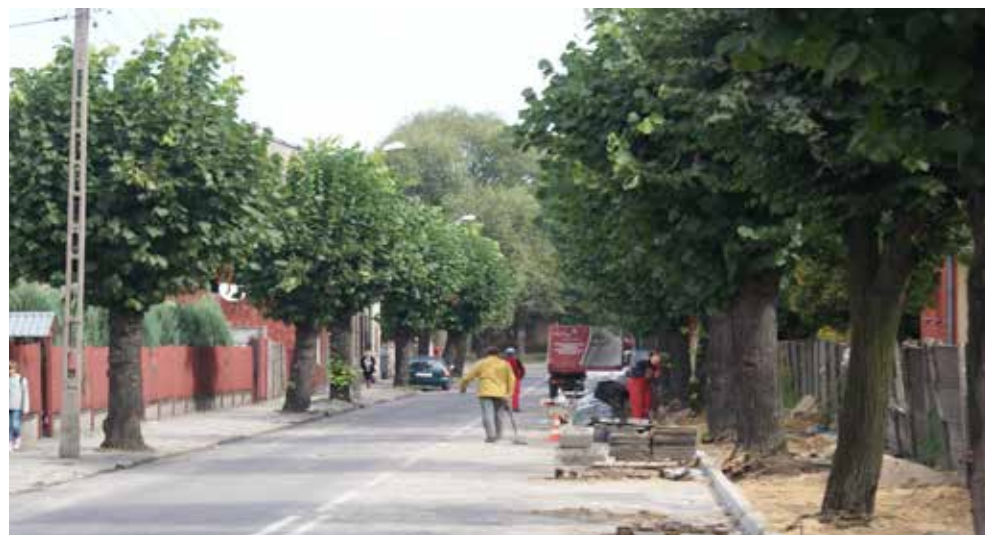
Wymiana chodnika na ul. Mielczarskiego, na odcinku od wjazdu do „DINO” do ul. Rembowski
