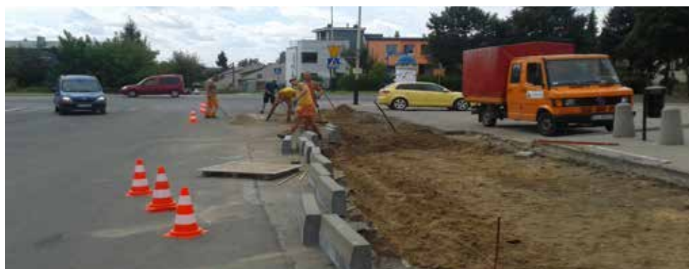
Przebudowa ulicy Stanisława Witkacego na odcinku od ul. Kamiennej do Tuwima – wykonanie nowej nakładki asfaltowej, chodników, zatok parkingowych, wysepek przystankowych i przejść dla pieszych, utwardzenie pobocza parkingu, wymiana krawężników
