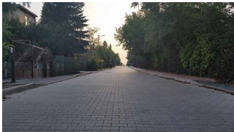
Budowa ul. Witosa
