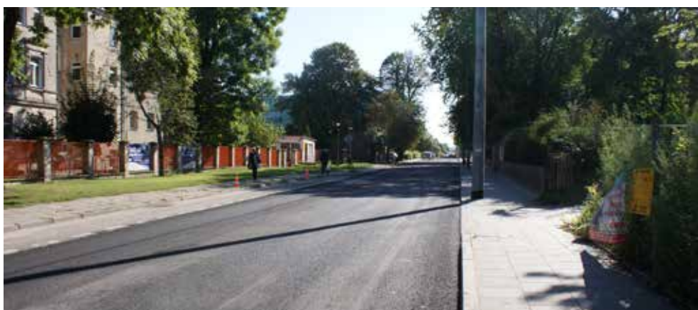
Położenie nowej nakładki asfaltowej na ul. Dubois (w trakcie prac)
