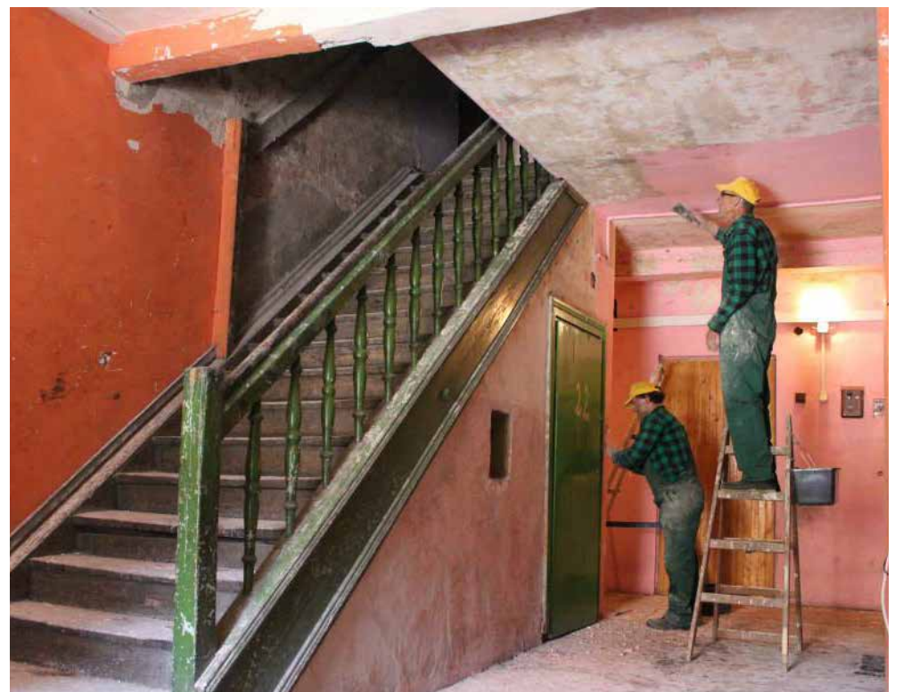
Remont klatki schodowej
