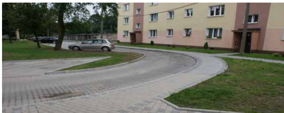
Remont nawierzchni dróg wewnętrznych chodników i parkingów na osiedlu „Okrzei” przy ul. 3 Maja 81 (pomiędzy blokami 4, 5, 8a) – wykonanie krawężników, obrzeży, nawierzchni jezdni z odzyskanych płyt chodnikowych oraz z kostki brukowej
