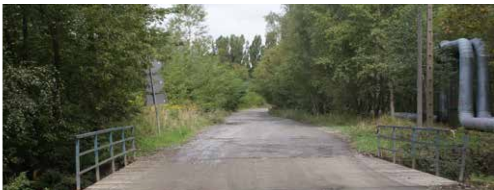
Remont mostu na ul. Miroszewskiej – I etap – naprawa poszycia jezdni
