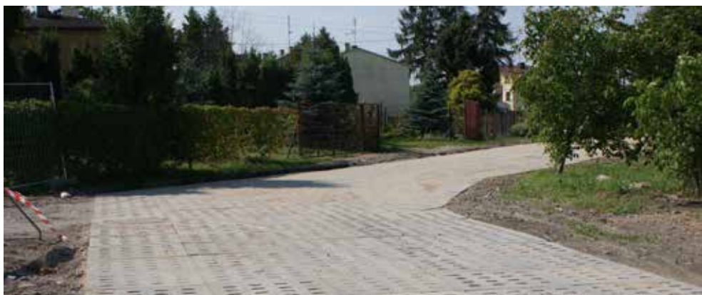
Przebudowa nawierzchni ul. Nowiny na odcinku od ul. Proboszczewice do ul. Perłowej oraz skrzyżowania ulicy Nowiny z ulicą Perłową – ułożenie płyt JOMB
