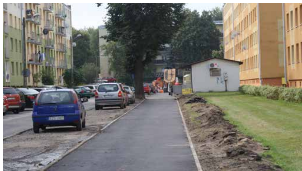
Remont chodnika wzdłuż ul. Spacerowej, na odcinku od ul. Długiej do ul. Rembowski
