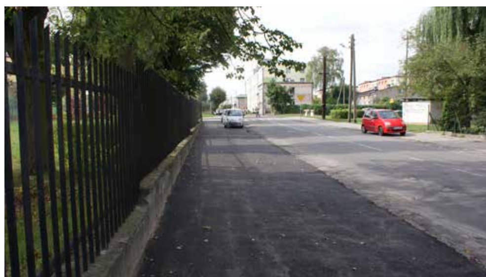
Remont chodnika wzdłuż ul. Rembowski, na odcinku od ul. Spacerowej do ul. Cezaka
