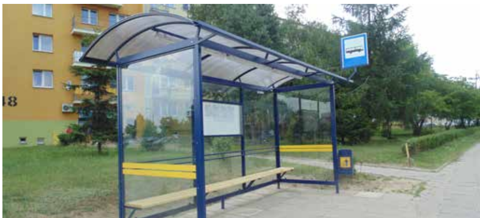
Nowa wiata na przystanku Gałczyńskiego/Tuwima
