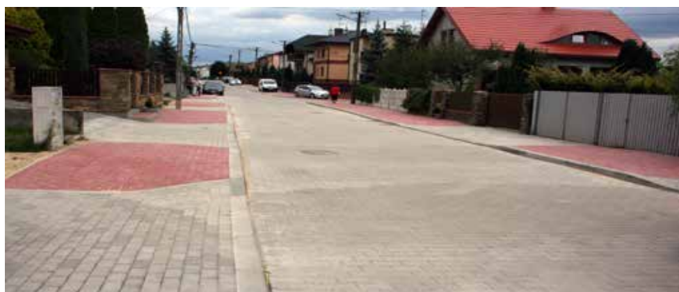
Budowa ul. Żytniej na odcinku od posesji nr 54 do posesji nr 66 – wykonanie jezdni, obustronnego chodnika, zjazdów indywidualnych
