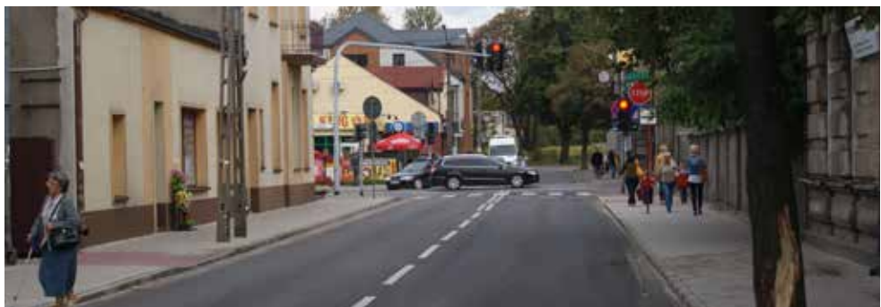
Remont ul. ks. Popieluszki na odcinku od ul. Długiej do ul. 3 Maja – wymiana krawężników, wykonanie chodników z kostki brukowej i położenie nowej warstwy ścieralnej z asfaltobetonu
