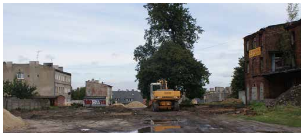
Początek przebudowy kwartału ulic
