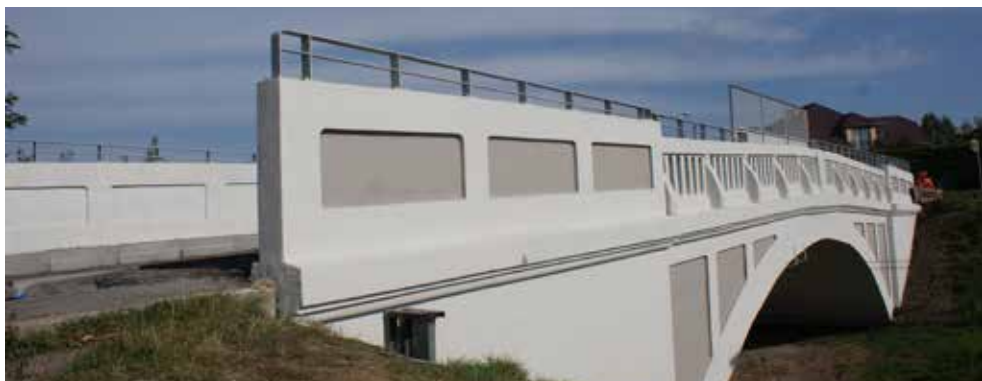
Remont wiaduktu na ul. Bolesława Czerwieńskiego oraz wykonanie nowej nawierzchni ulicy i jednostronnego chodnika.
