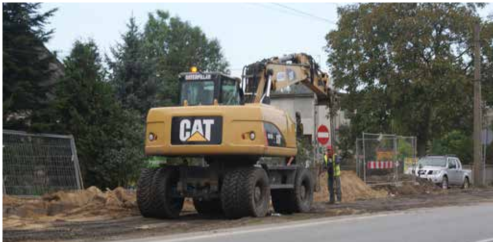
Budowa kanalizacji w ul. Ozorkowskiej
