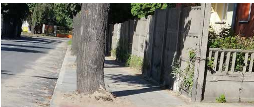
Remont chodnika przy ul. Mielczarskiego
