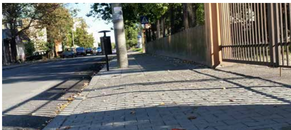
Remont chodnika przy ul. Dubois
