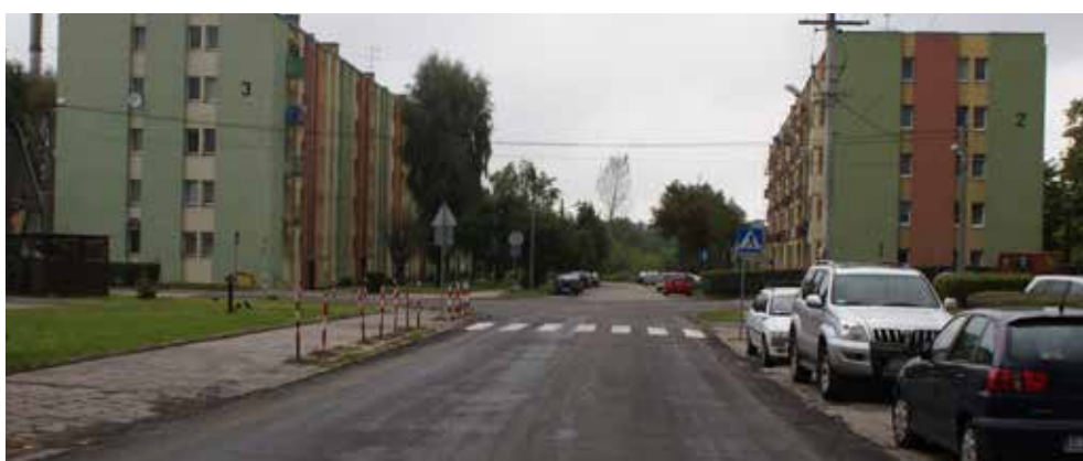
Wykonanie nakładki asfaltowej przy ul. Cezaka
