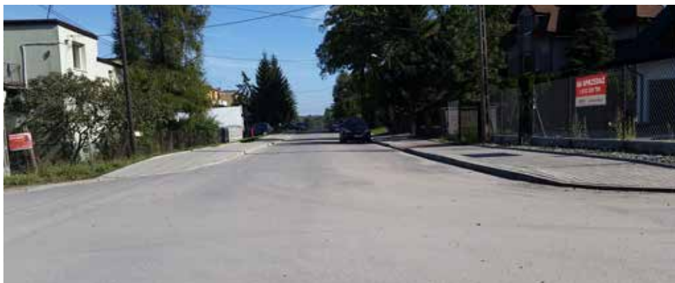
Budowa drogi przy ul. Zawiszy
