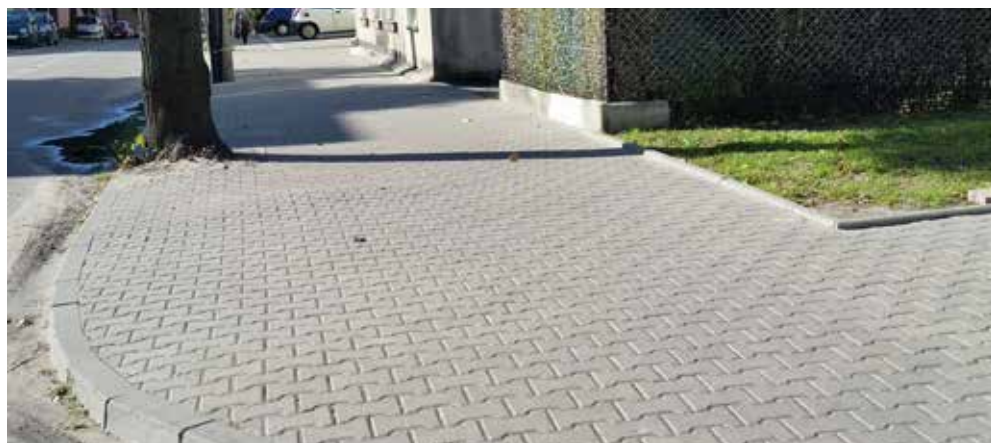
Remont chodnika przy ul. Rembowskiego
