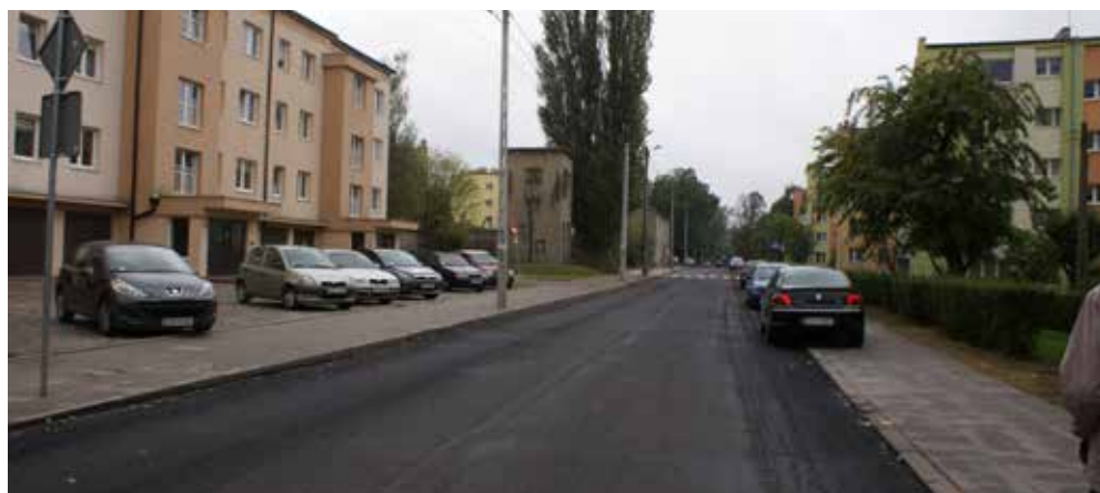
Wykonanie nakładki asfaltowej przy ul. Dubois
