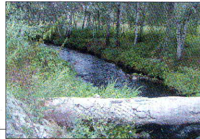
Widok spod mostu na ul. Aleksandrowskiej. Woda brudna, całość sprawia wrażenie ścieku mimo intensywnej zieleni.
