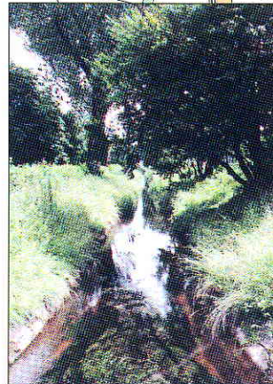
Widok z mostu na ulicy 1. Maja w stronę wschodnią. Koryto zwężone, brzegi porośnięte, wzmocnione płytami, brak dostępu do wody. Od tego miejsca zarysowuje się bardziej naturalny charakter rzeki.
