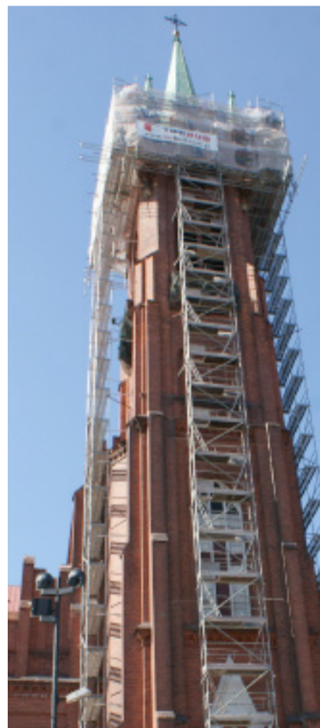
Dofinansowanie remontu atyki wieży kościoła farnego pw. św. Katarzyny.
