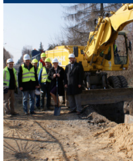
Budowa kanalizacji deszczowej w ul. Witosy, na odcinku od ul. Ozorkowskiej do posesji nr 26.
