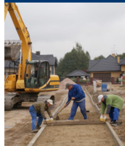
Budowa ulicy Zawiszy na odcinku od ulicy Łagiewnickiej w stronę rzeki Bzury – I etap inwestycji.
