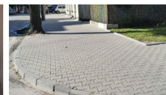
Remont chodnika przy ulicy Rembowskiego
