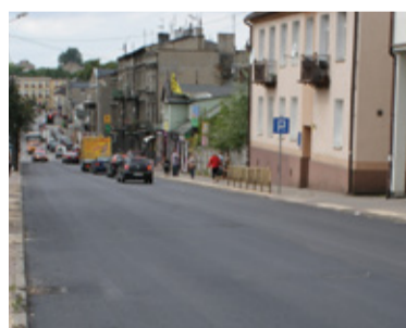
Remont nawierzchni ul. Długiej na odcinku od ul. Narutowicza do ul. Popietuszkii.
