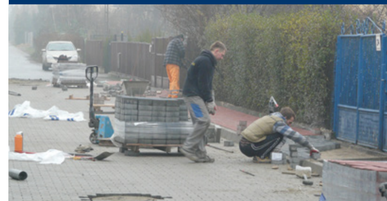
Budowa ul. Witosy – I etap inwestycji.
