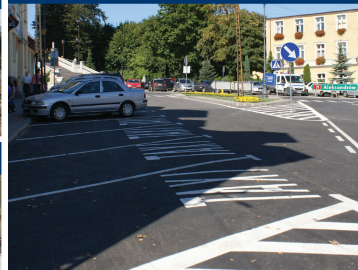
Przebudowa ulicy Głowackiego wraz z fragmentem ul. Łódzkiej i pl. Jana Pawła II w Zgierzu.
